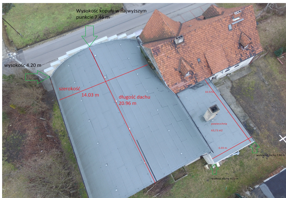
Zdjęcie 2. Stan obecny pokrycia dachowego – wymiary dachu
